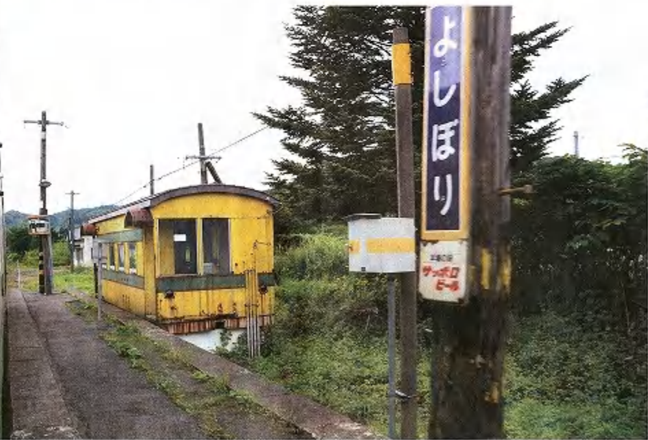
貨物列車の車庫車を改造した黄色の駅舎が目を引く吉堀駅
